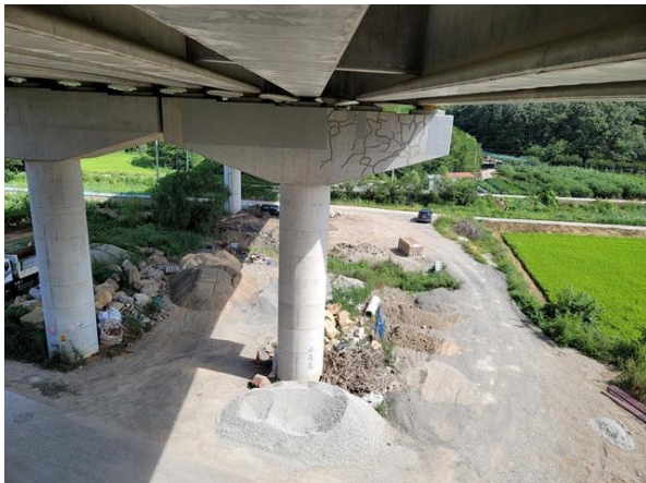
교각 P1 기초 전경
