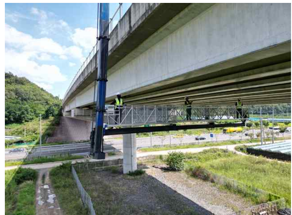
굴절작업차를 이용한 근접조사
