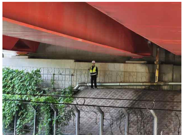
도보를 이용한 근접조사
