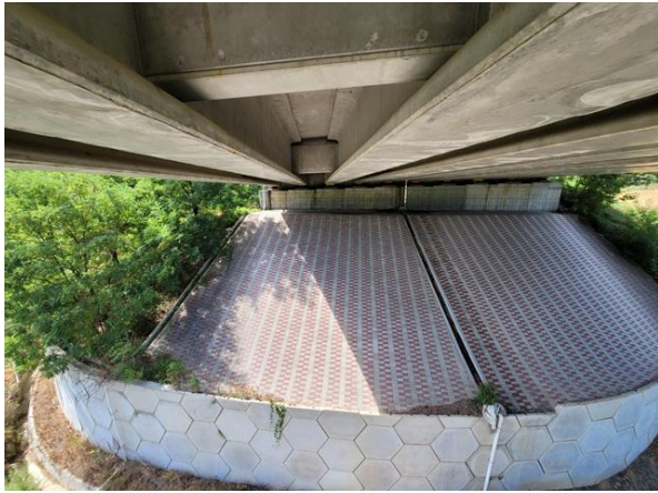
교대 A1 기초 전경
