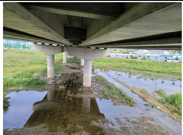
교각 P2 기초 전경
