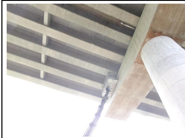
고소점검차를 이용한 근접조사
