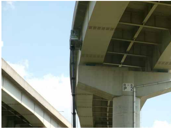
고소점검차를 이용한 부재치수 현장측정
