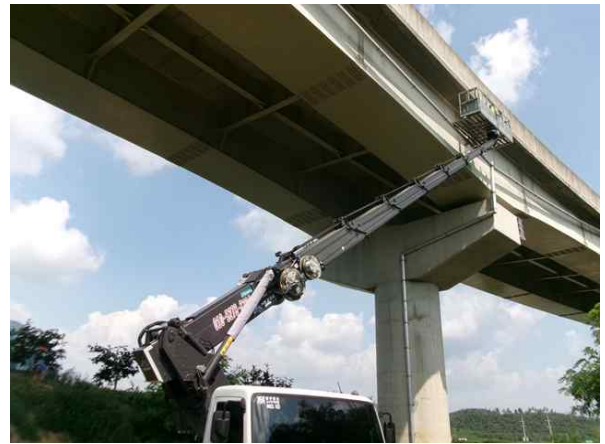
고소작업차를 이용한 근접조사
