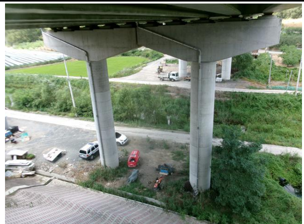
교각 P3 기초 전경
