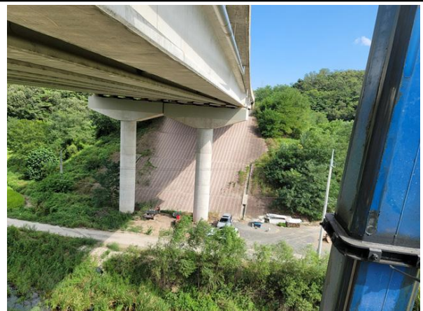
교각 P3 기초 전경
