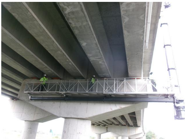
굴절점검차를 이용한 근접조사
