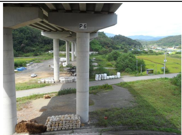
교각 P6 기초 전경
