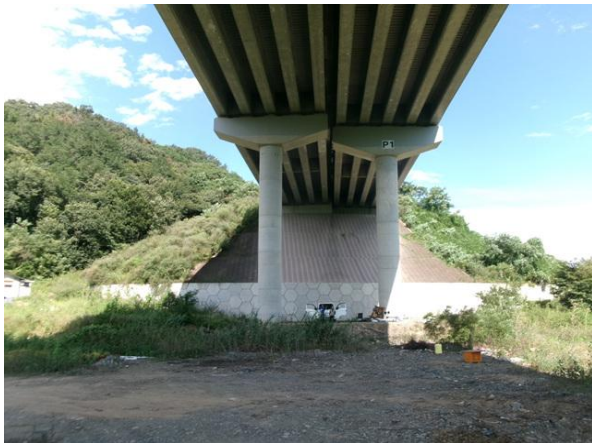
교대 A1 기초 전경
