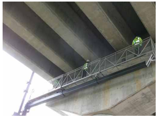
굴절작업차를 이용한 부재치수 현장측정
