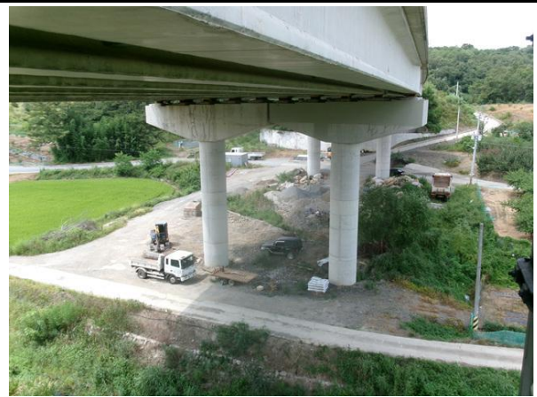
교각 P2 기초 전경
