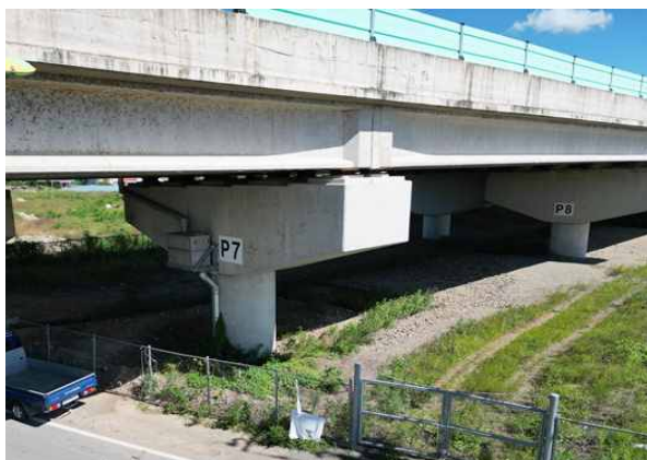
교각 P7~8 기초 전경
