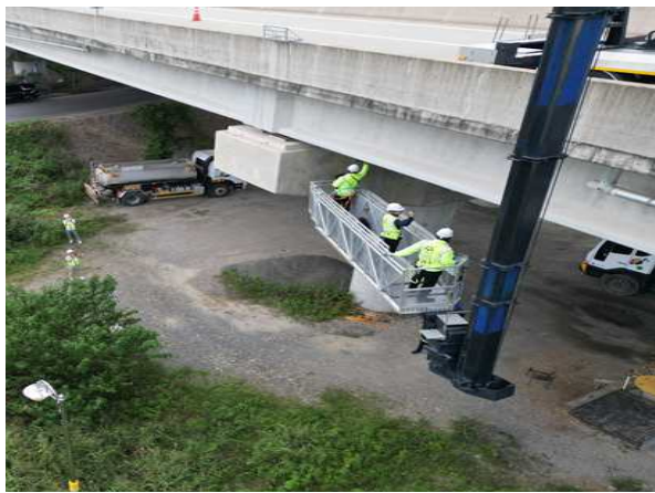
굴절작업차를 이용한 부재치수 현장측정
