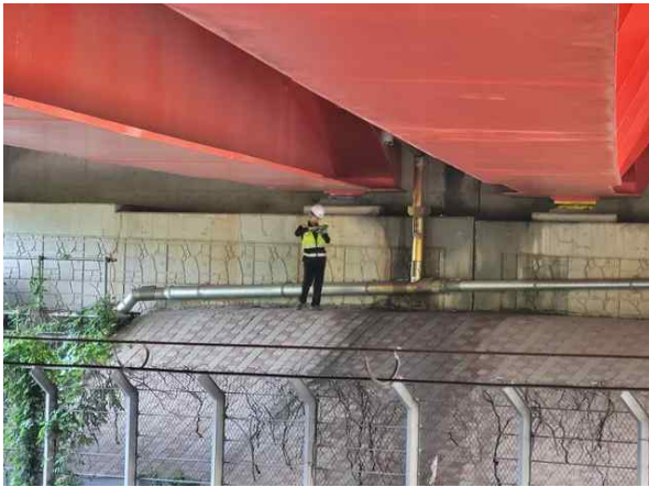
거리측정기를 이용한 부재치수 현장측정
