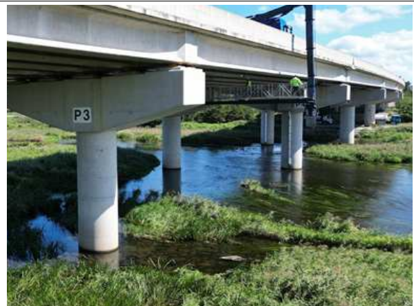
교각 P3~6 기초 전경
