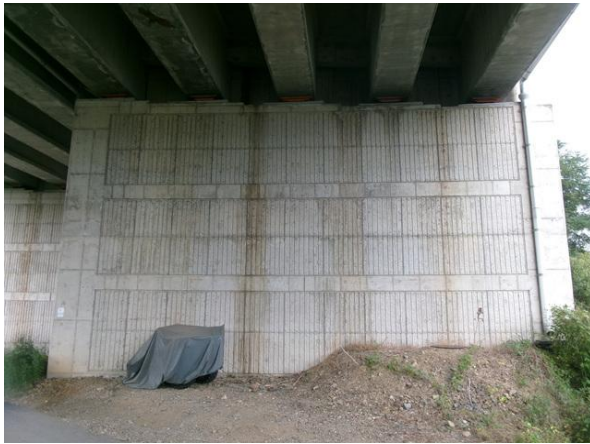
교대 A1 기초 전경
