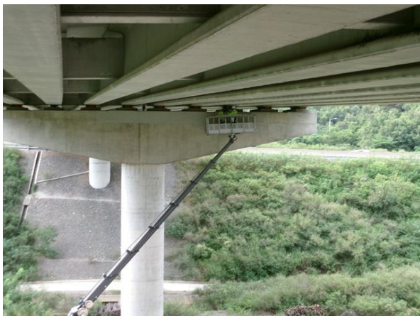
고소점검차를 이용한 근접조사
