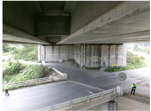
교대 A2 기초 전경
