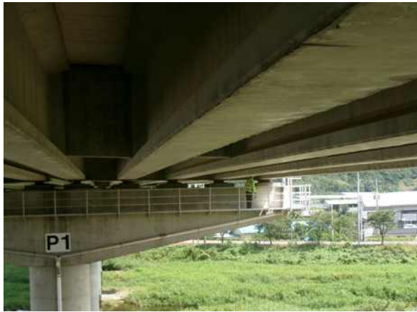
도보점검을 이용한 부재치수 현장측정
