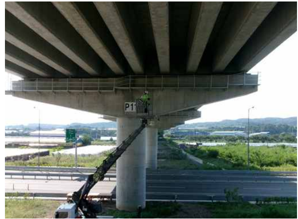
고소작업차를 이용한 부재치수 현장측정
