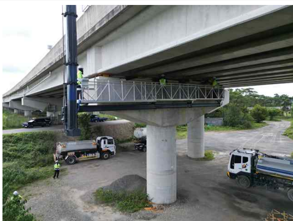
굴절작업차를 이용한 근접조사
