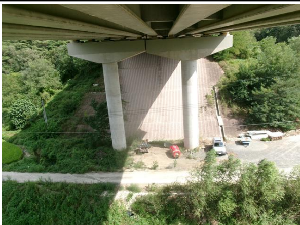
교각 P3 기초 전경
