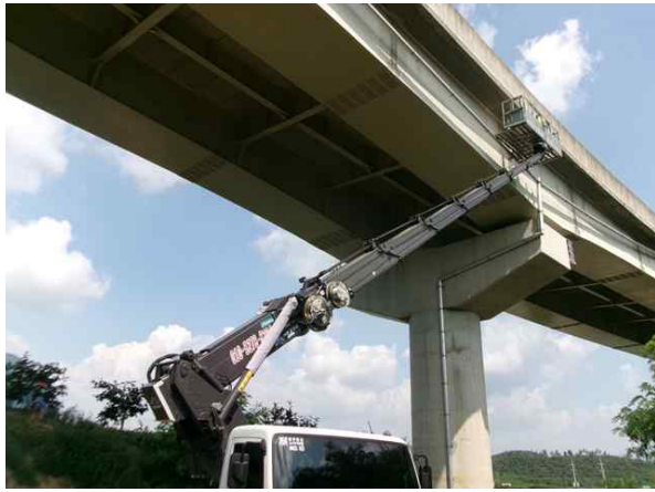
고소점검차를 이용한 부재치수 현장측정
