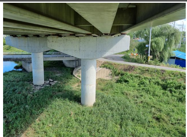
교각 P3 기초 전경
