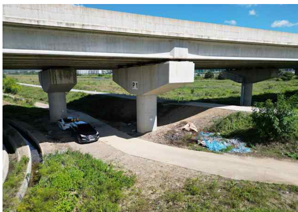
교각 P1 기초 전경
