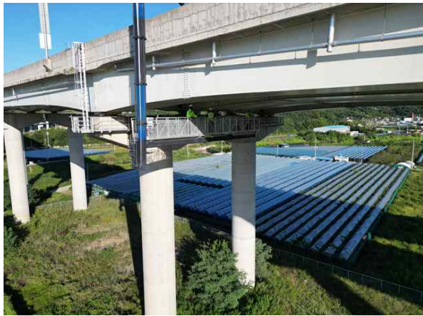
굴절작업차를 이용한 근접조사
