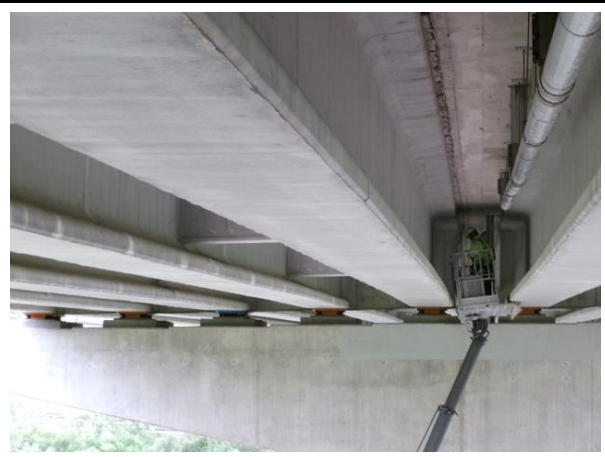
고소점검차를 이용한 근접조사
