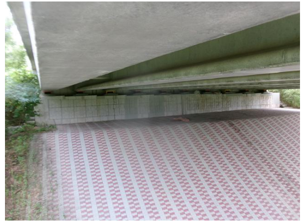
교대 A2 기초 전경
