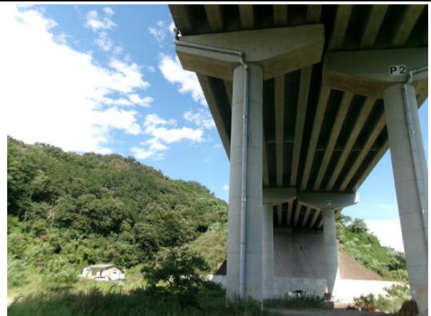
교각 P2 기초 전경
