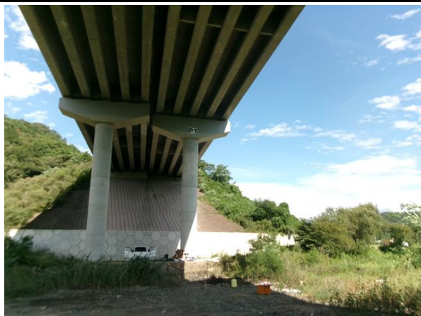
교각 P1 기초 전경
