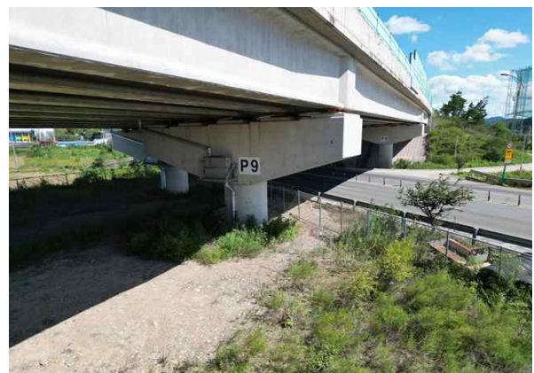
교각 P9~10 기초 전경
