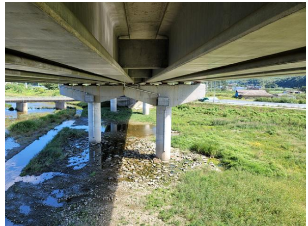
교각 P2 기초 전경
