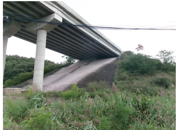
교대 A2 기초 전경
