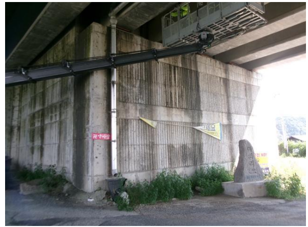
교대 A2 기초 전경
