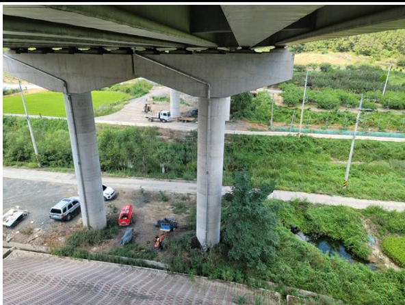
교각 P3 기초 전경
