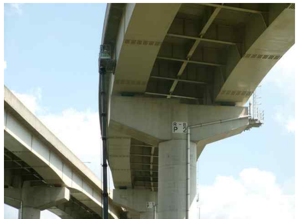
고소작업차를 이용한 근접조사
