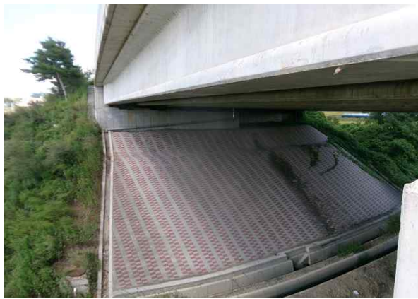
교대 A1 기초 전경
