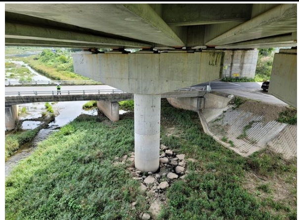
교각 P3 기초 전경
