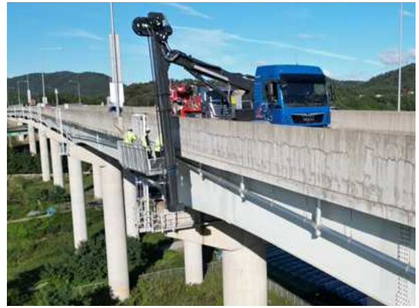
굴절작업차를 이용한 부재치수 현장측정
