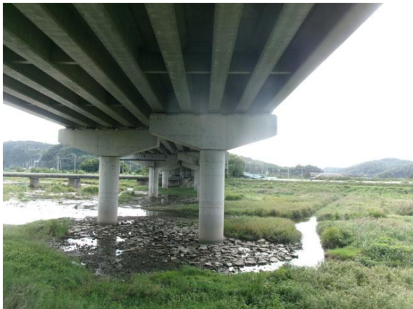
교각 P1 기초 전경
