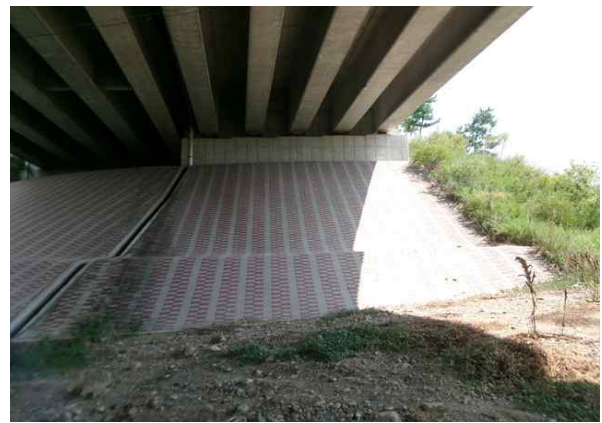
교대 A2 기초 전경
