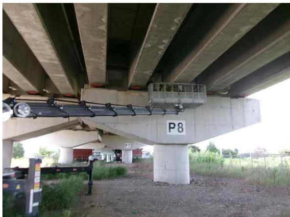
고소차를 이용한 근접조사
