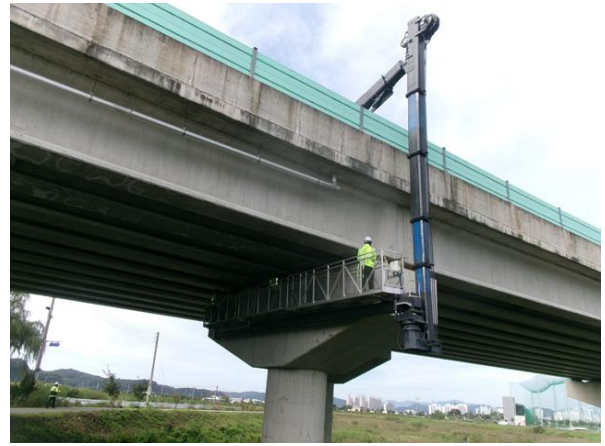
굴절점검차를 이용한 근접조사
