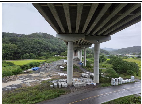
교각 P5 기초 전경
