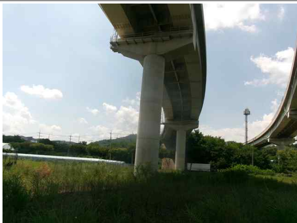
교각 P2 기초 전경
