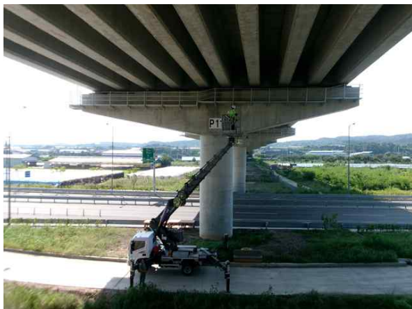
고소점검차를 이용한 근접조사
