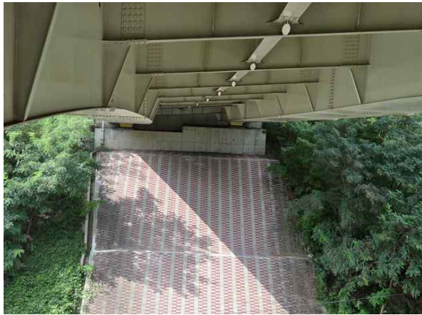
교대 A1 기초 전경
