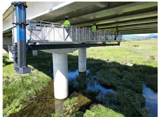
굴절작업차를 이용한 근접조사
