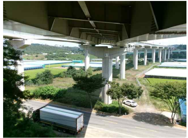
교각 P1 기초 전경
