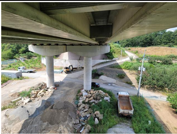
교각 P1 기초 전경
