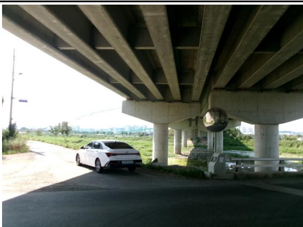
교각 P3 기초 전경
