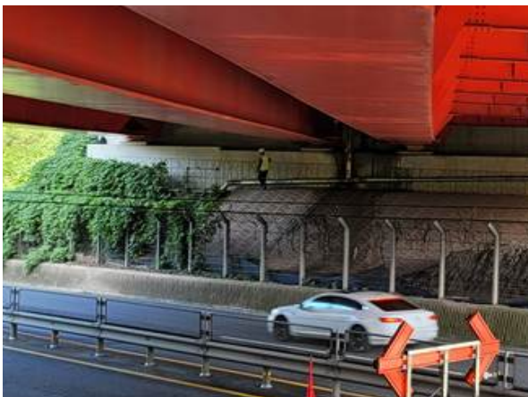
도보를 이용한 근접조사
