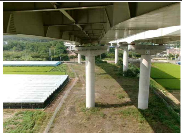
교각 P3 기초 전경
