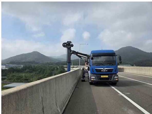
굴절작업차를 이용한 근접조사
