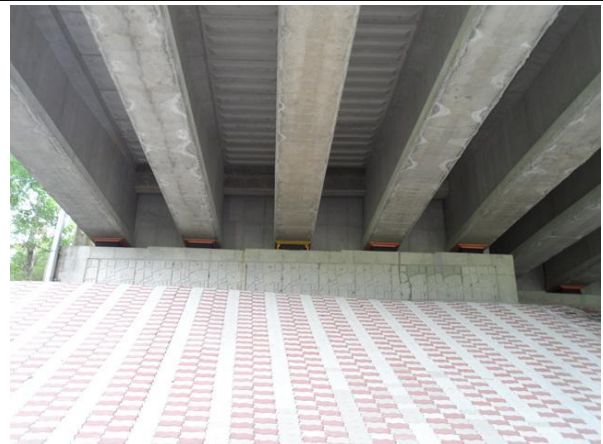
교대 A2 기초 전경
