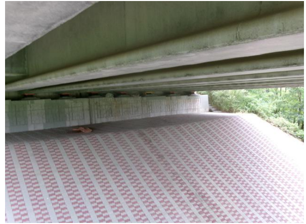
교대 A2 기초 전경
