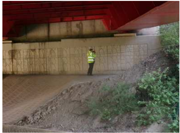
줄자를 이용한 부재치수 현장측정
