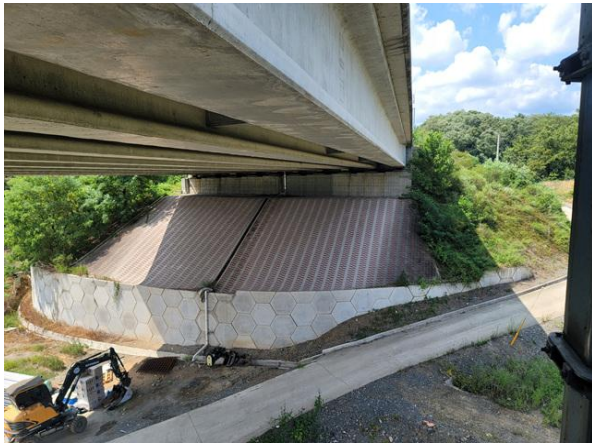
교대 A1 기초 전경
