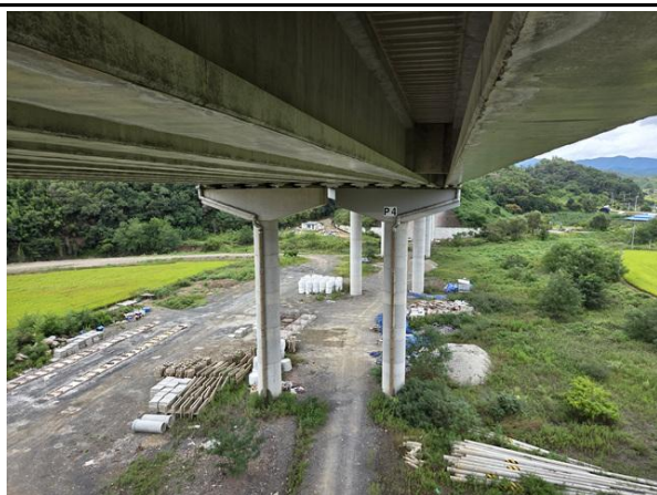
교각 P4 기초 전경
