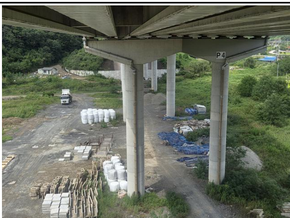
교각 P4 기초 전경
