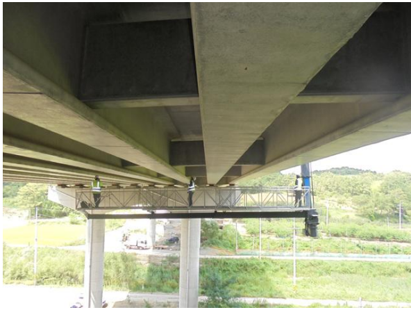
교량점검차를 이용한 근접조사
