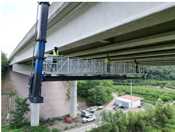
교량점검차를 이용한 근접조사
