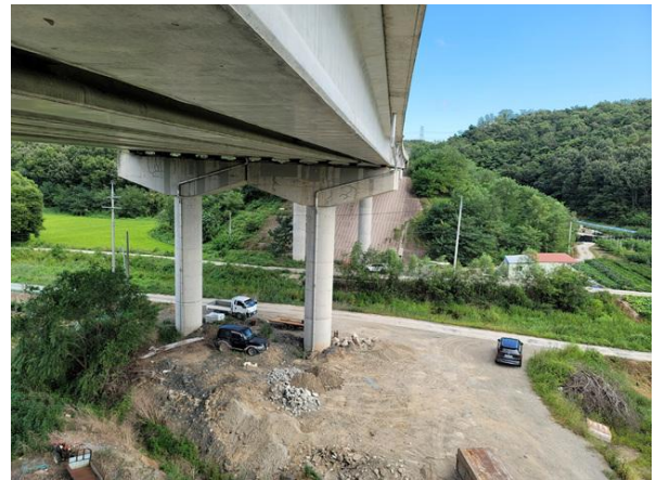
교각 P2 기초 전경
