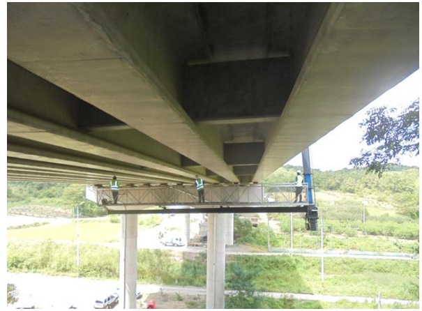
교량점검차를 이용한 근접조사
