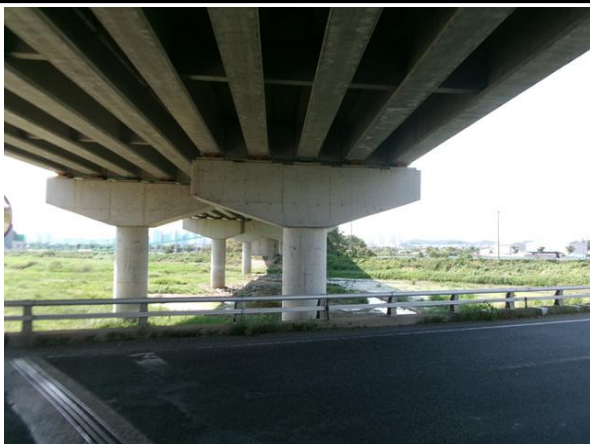
교각 P3 기초 전경
