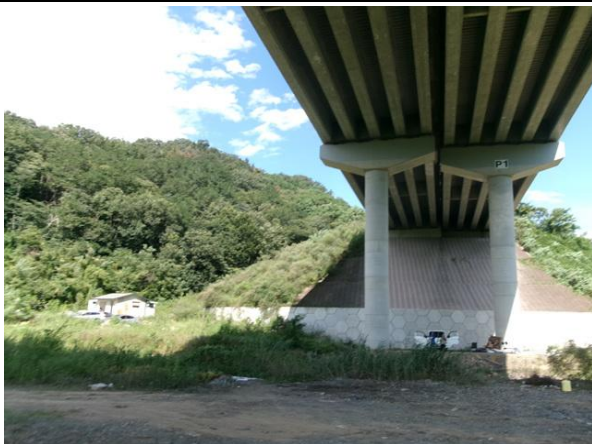
교각 P1 기초 전경
