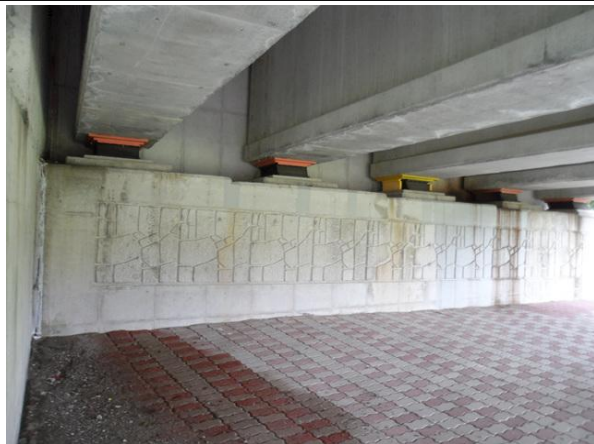
교대 A1 기초 전경
