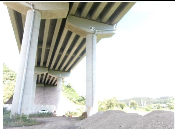
교각 P2 기초 전경
