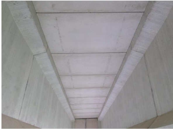
거더 및 바닥판하면 전경
