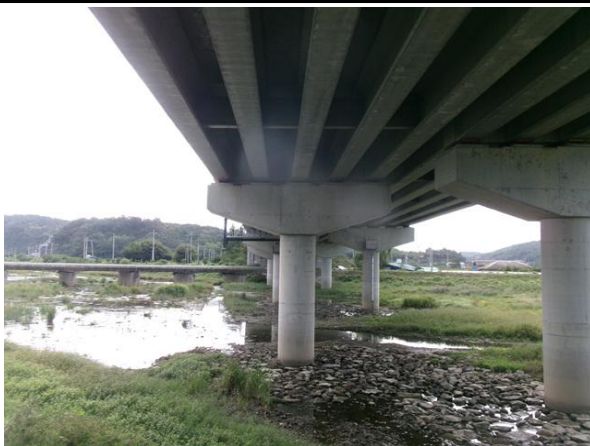
교각 P1 기초 전경
