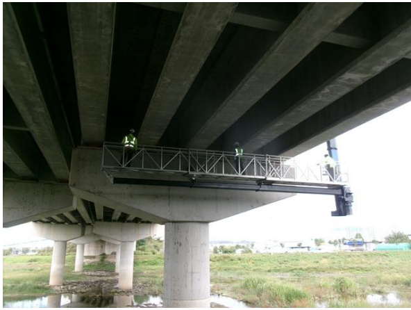
굴절점검차를 이용한 근접조사
