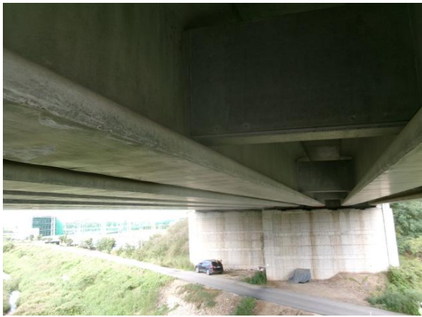
교대 A1 기초 전경
