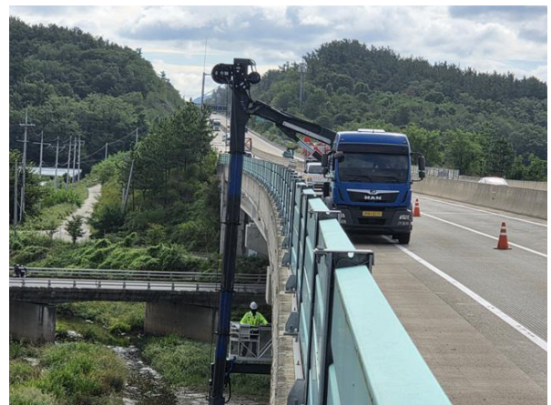
굴절점검차를 이용한 근접조사
