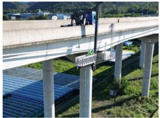
굴절작업차를 이용한 부재치수 현장측정
